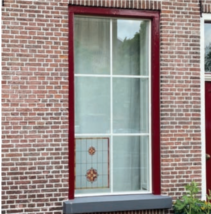
▲ Afbeelding XXVII Voormalig schuifraam waarbij het bovenlicht en onderraam zijn vervangen door één plaat dubbelglas die direct in het kozijn is vastgezet met glaslatten, met kunststof roeden in de spouw van het dubbelglas.
