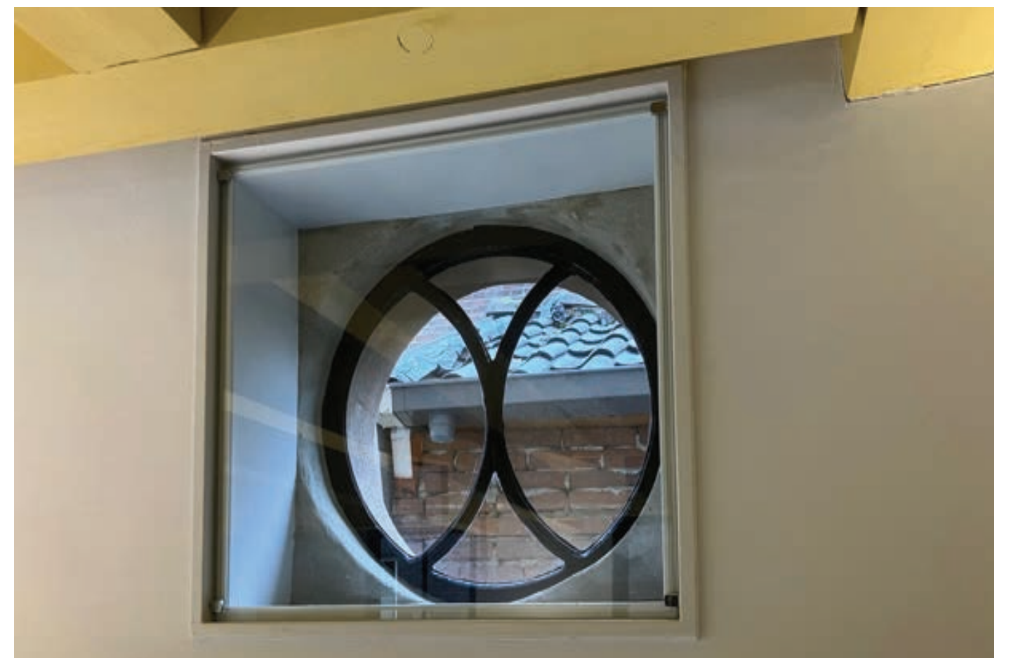
▲ Afbeelding IX Achterzetraam opgenomen in een geïsoleerde voorzetwand
