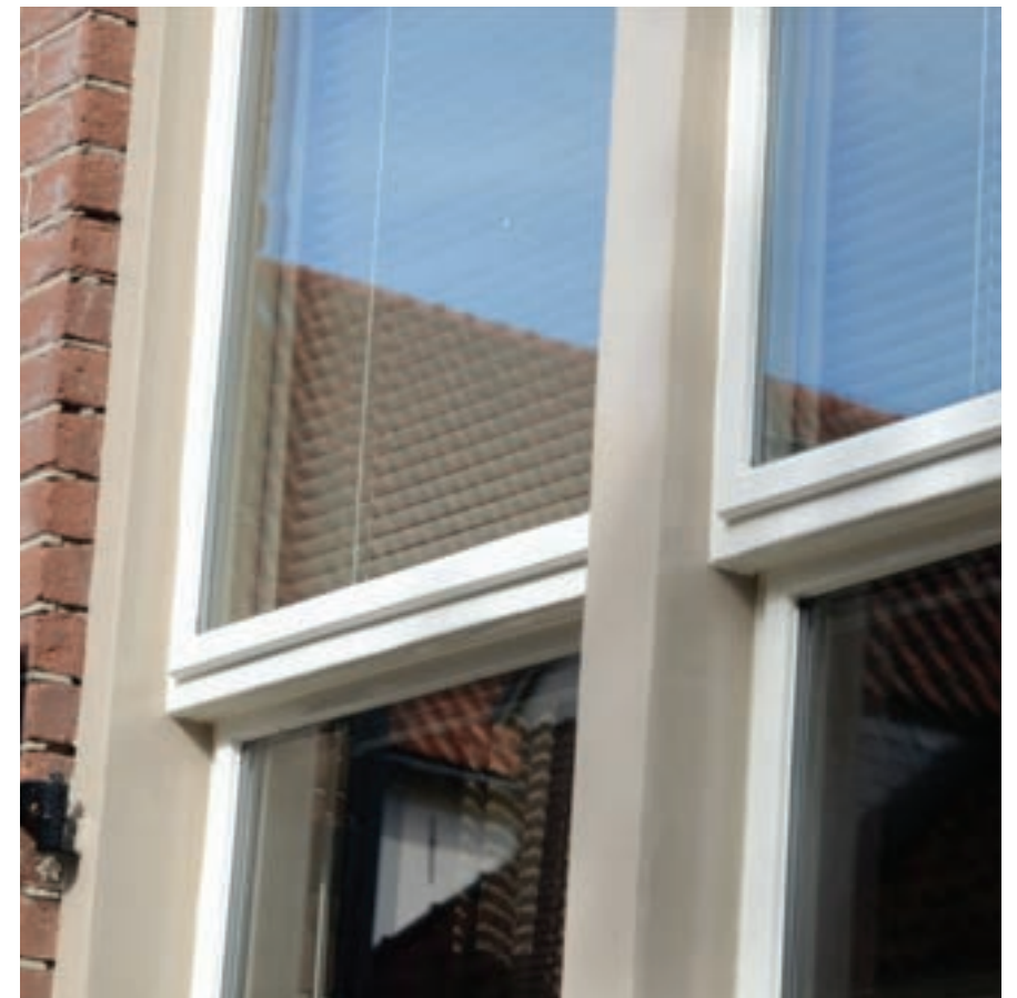
▲ Afbeelding XXXII Schuiframen met opdeklaten vanwege het plaatsen van isolatieglas. Door de latten schuift het onderraam niet meer omhoog en is het aanzicht gewijzigd.
