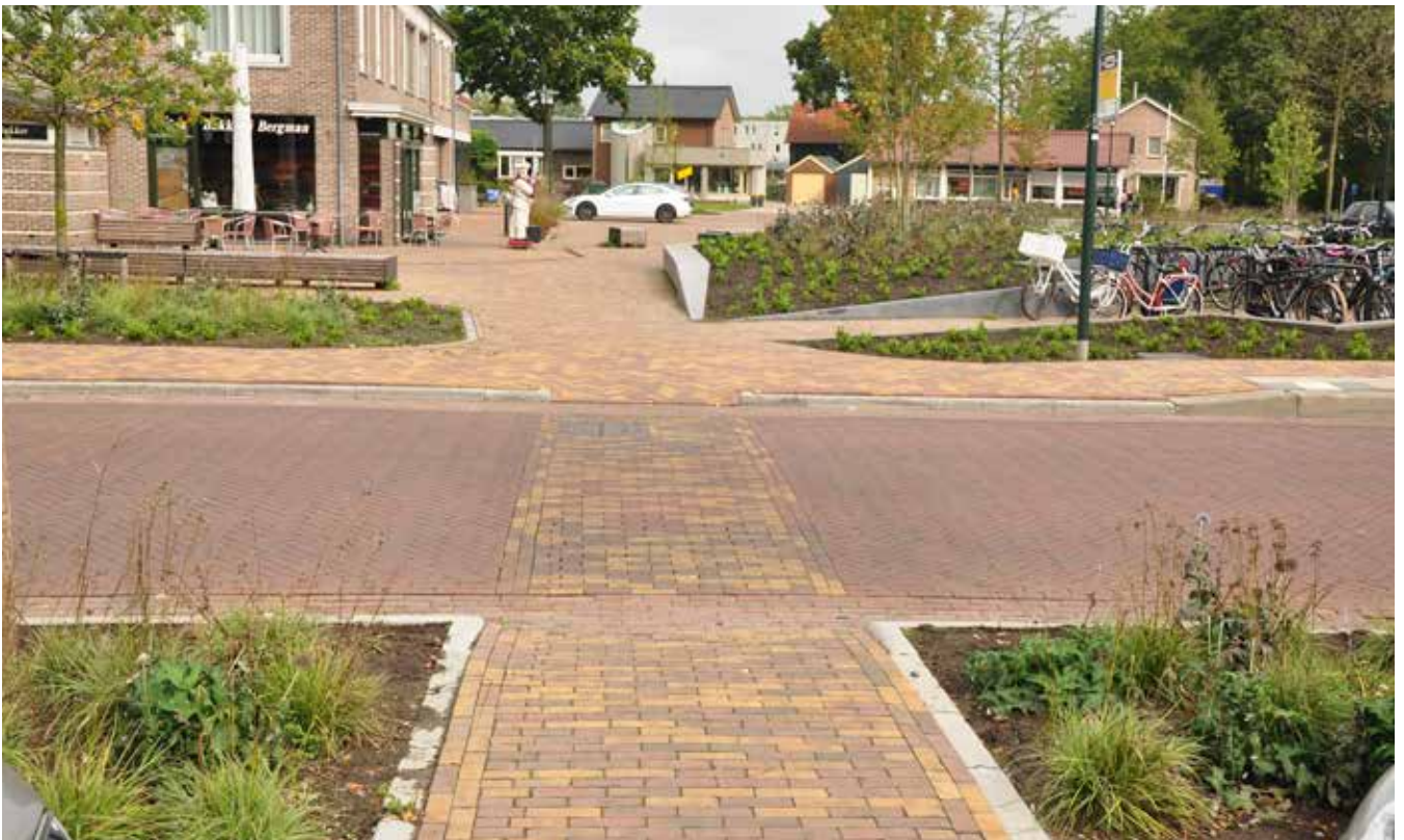
Voorbeeld gelijkvloerse oversteek zonder obstakels, geschikt voor minder validen (Piet Soerplein, Havelte)
