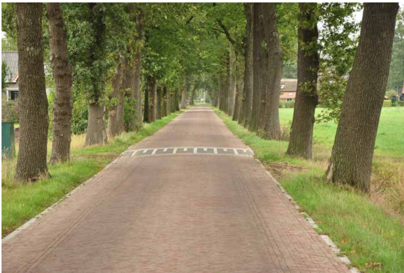
Voorbeeld bovengrondse afvoer vanaf de weg direct op de berm (Lheebroekerweg, Lheebroek)
