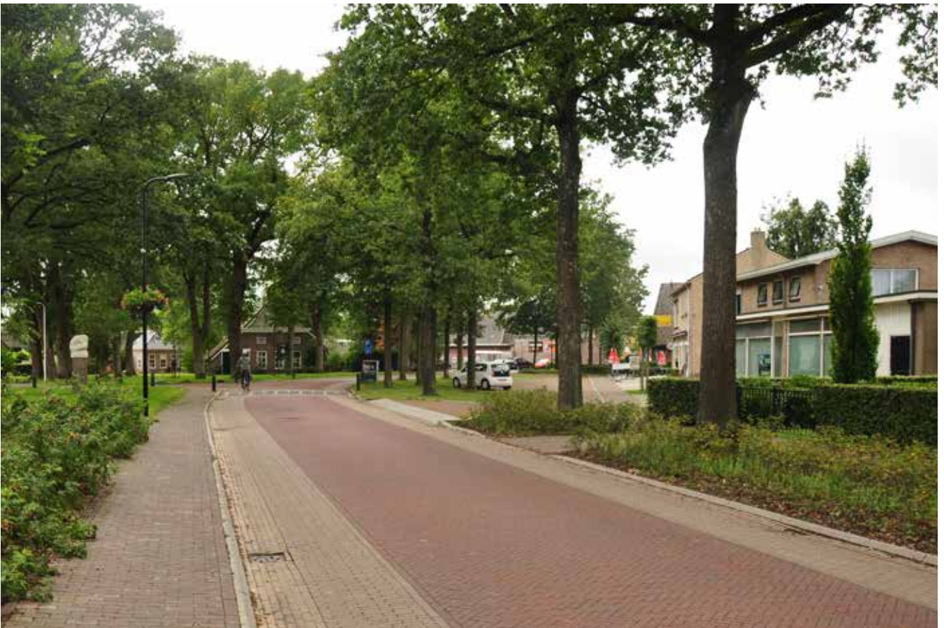
Voorbeeld van weg binnen de bebouwde kom met rabatstroken in andere kleur en aanliggend voetpad (Dorpsstraat, Vledder)
