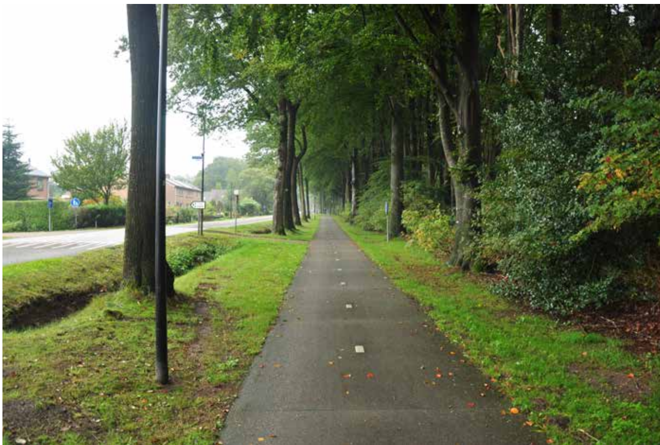
Voorbeeld van vrijliggend verkeersfietspad in asfalt (Ruiterweg, Havelterberg)
