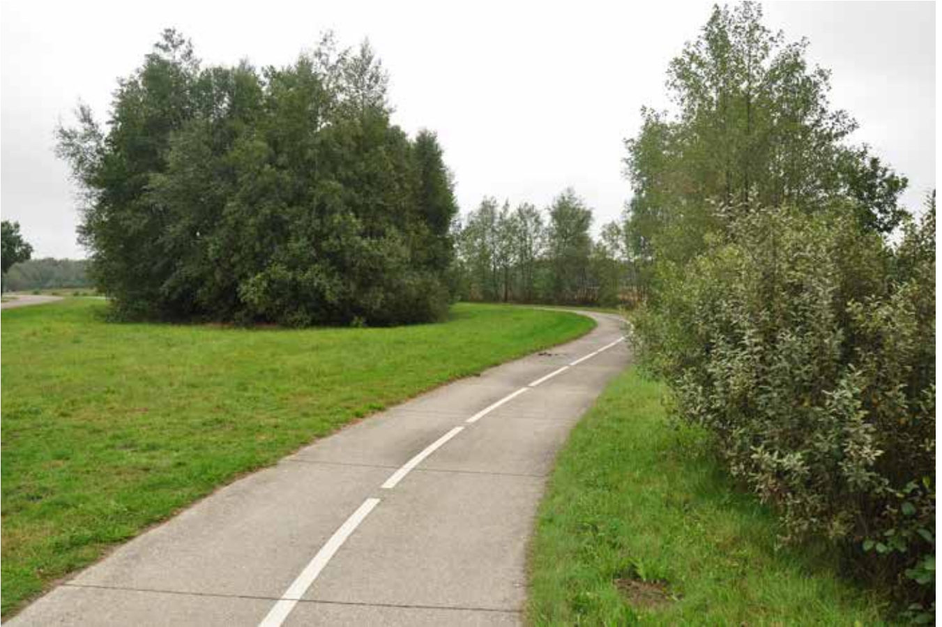
Voorbeeld van verkeersfietspad in beton (Wateren)
