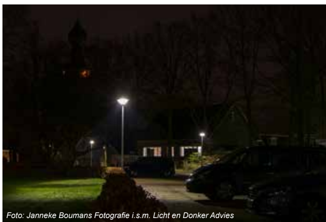
Achterpaden, paaltop 3,5 meter LED, evt. met detectie
