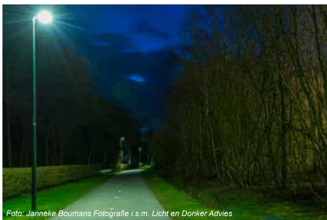
Vrijliggende fietspaden paal 5 meter met toppaal armatuur LED dimbaar
