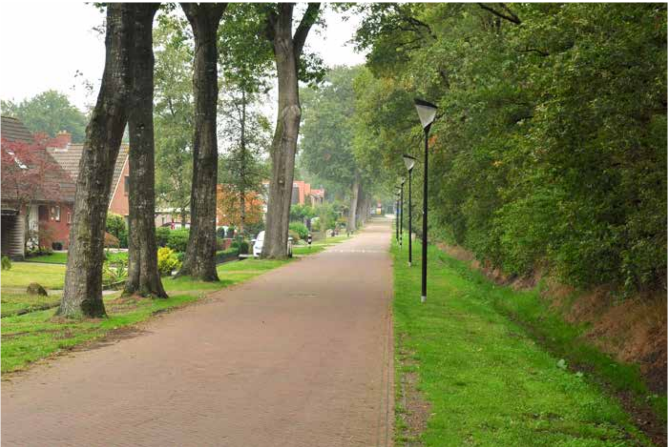
Voorbeeld standaard berm-sloot (Kamperweg, Darp)
