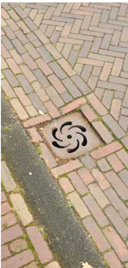
Kolkdeksel HWA met waaiermotief
