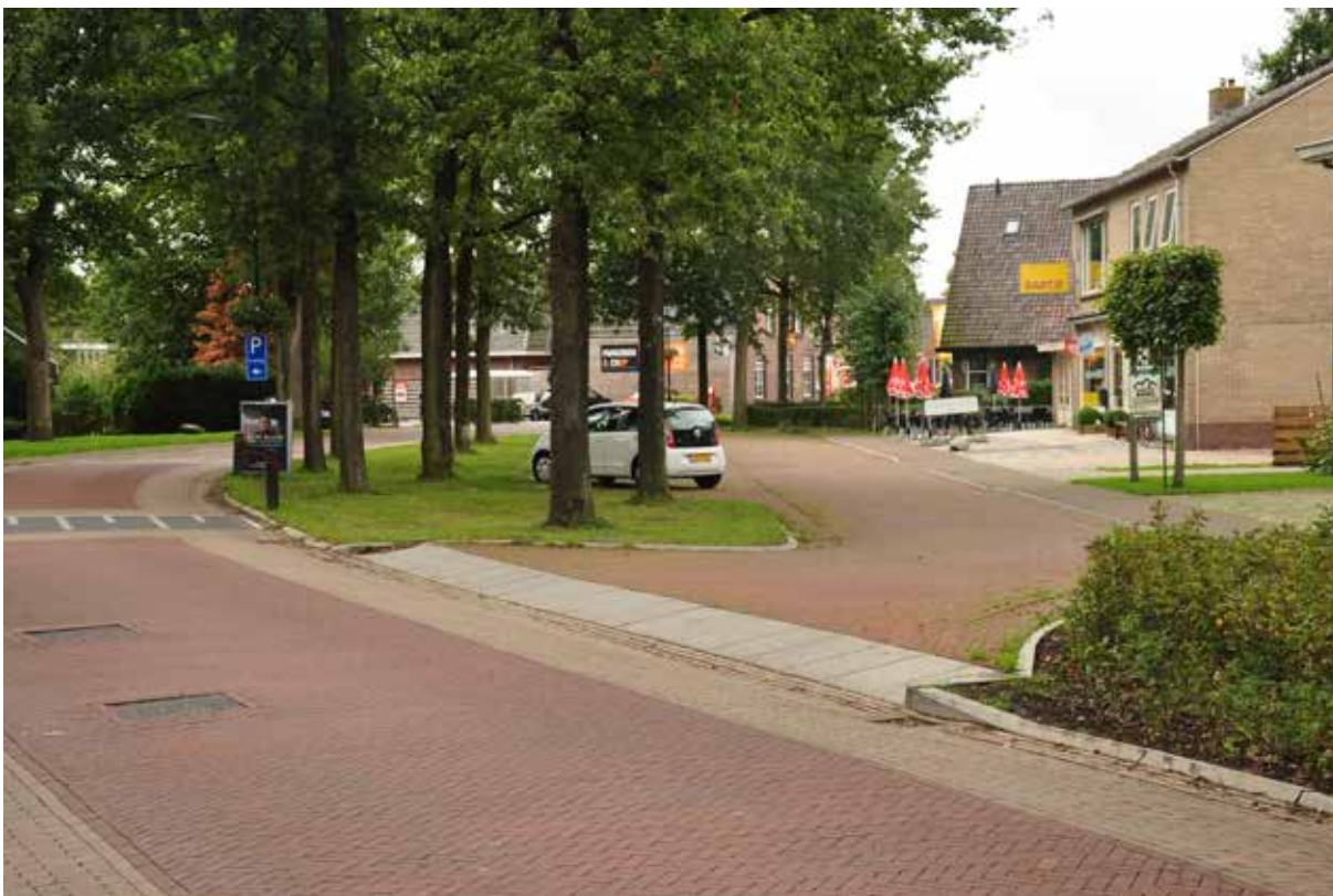
Voorbeeld van inritconstructie (Dorpsstraat, Vledder)
