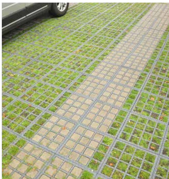
Voorbeeld infiltratie hemelwater (Brink, Havelte)
