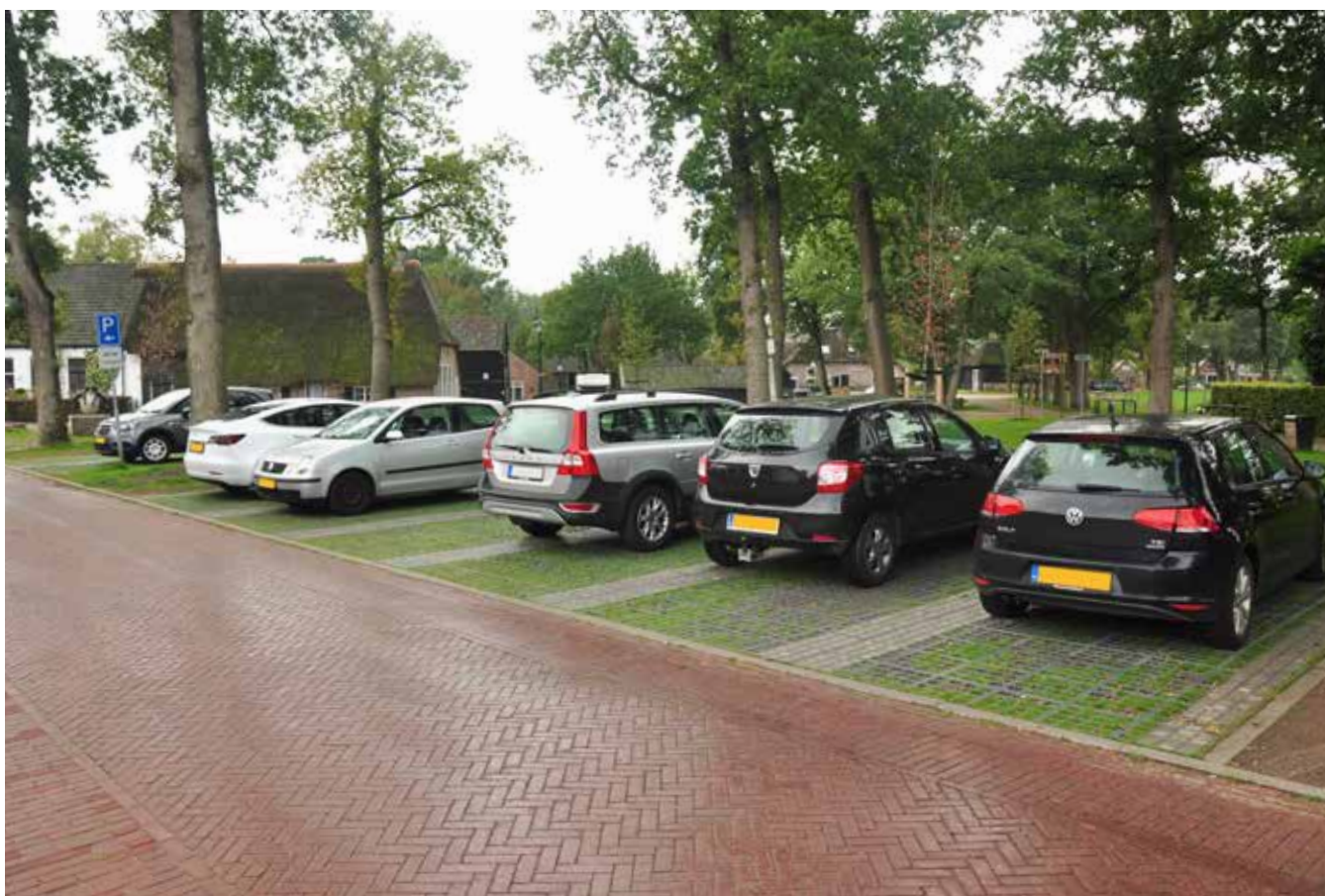
Voorbeeld haaksparkeren op grastegels, stroken steen tussen de vakken zorgen voor goede toegankelijkheid (Brink, Havelte)
