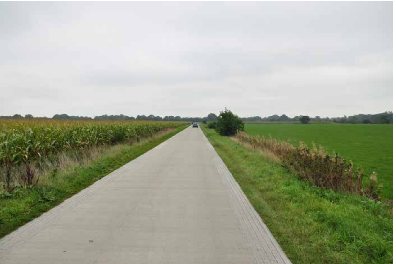
Voorbeeld van weg buiten de bebouwde kom met betonverharding (Wallingeresweg, Havelte)
