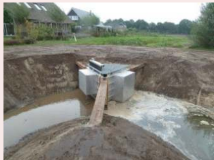
Stuw, links: stedelijk water, rechts: water uit de eco-zone
