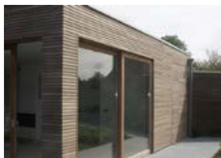
Houten gevels in donkere kleuren
