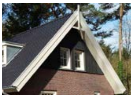
Zadeldak met houten topgevel
